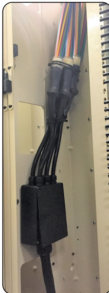
Durante la Instalación
