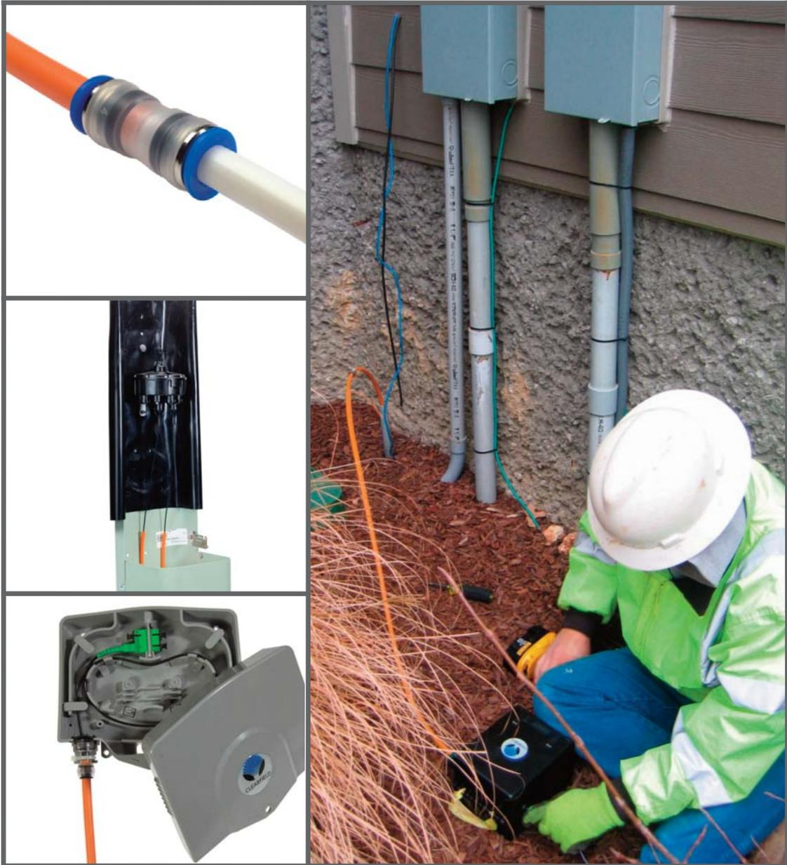
**FieldShield es un nuevo** método de protección y entrega de fibra que apunta hacia la reducción del costo de “la última milla” de la implementación de banda ancha con fibra empujable.
